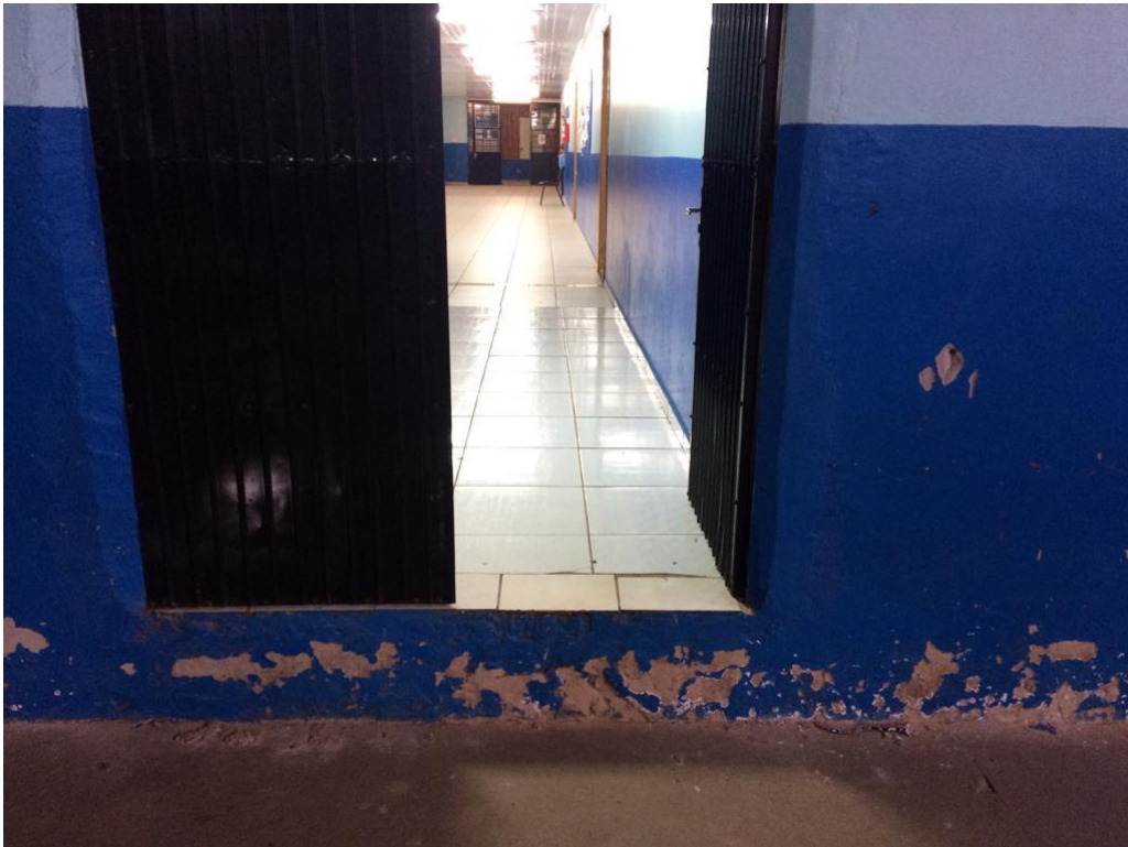
Local a ser construída rampa para acessar a quadra de esportes.
