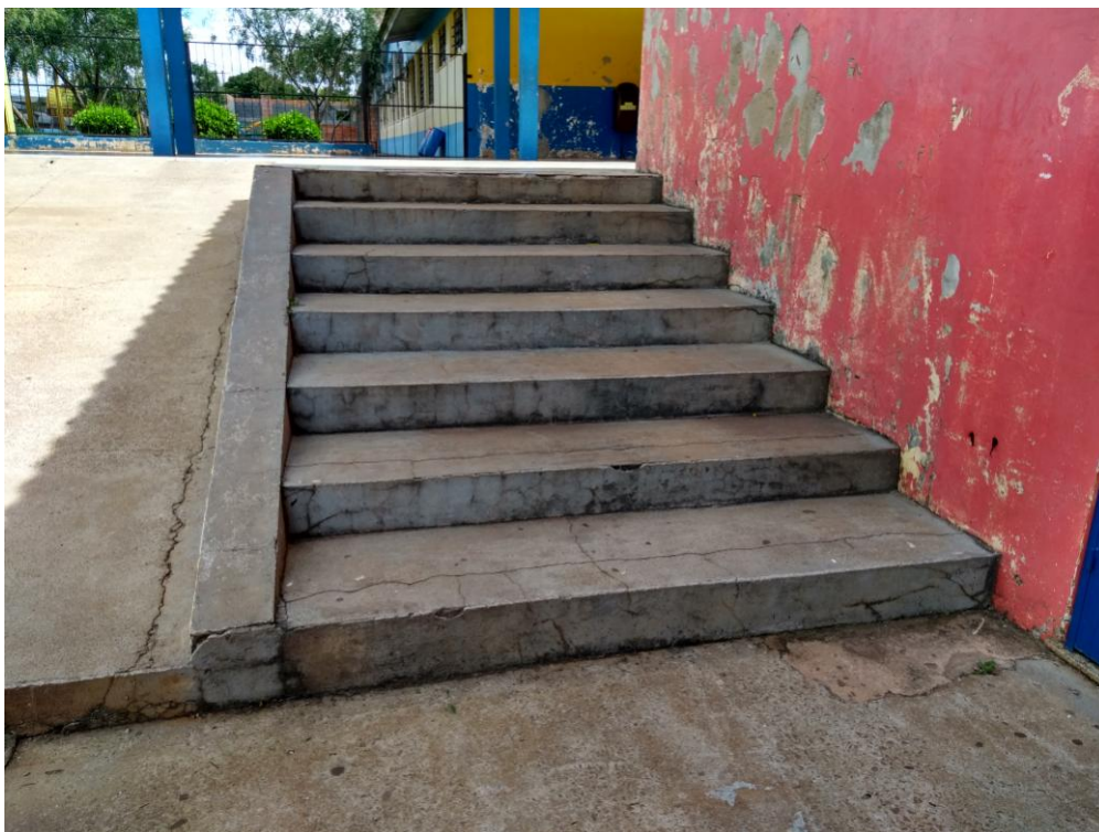
Escada a ser demolida para a posterior construção de uma rampa.
