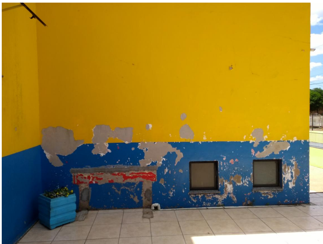
Exemplo de local onde somente a pintura existente na parede deverá ser removida.
