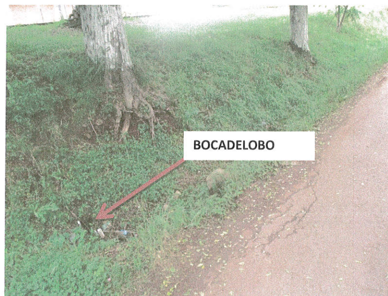
Figura 17: Situação das bocas de lobo
