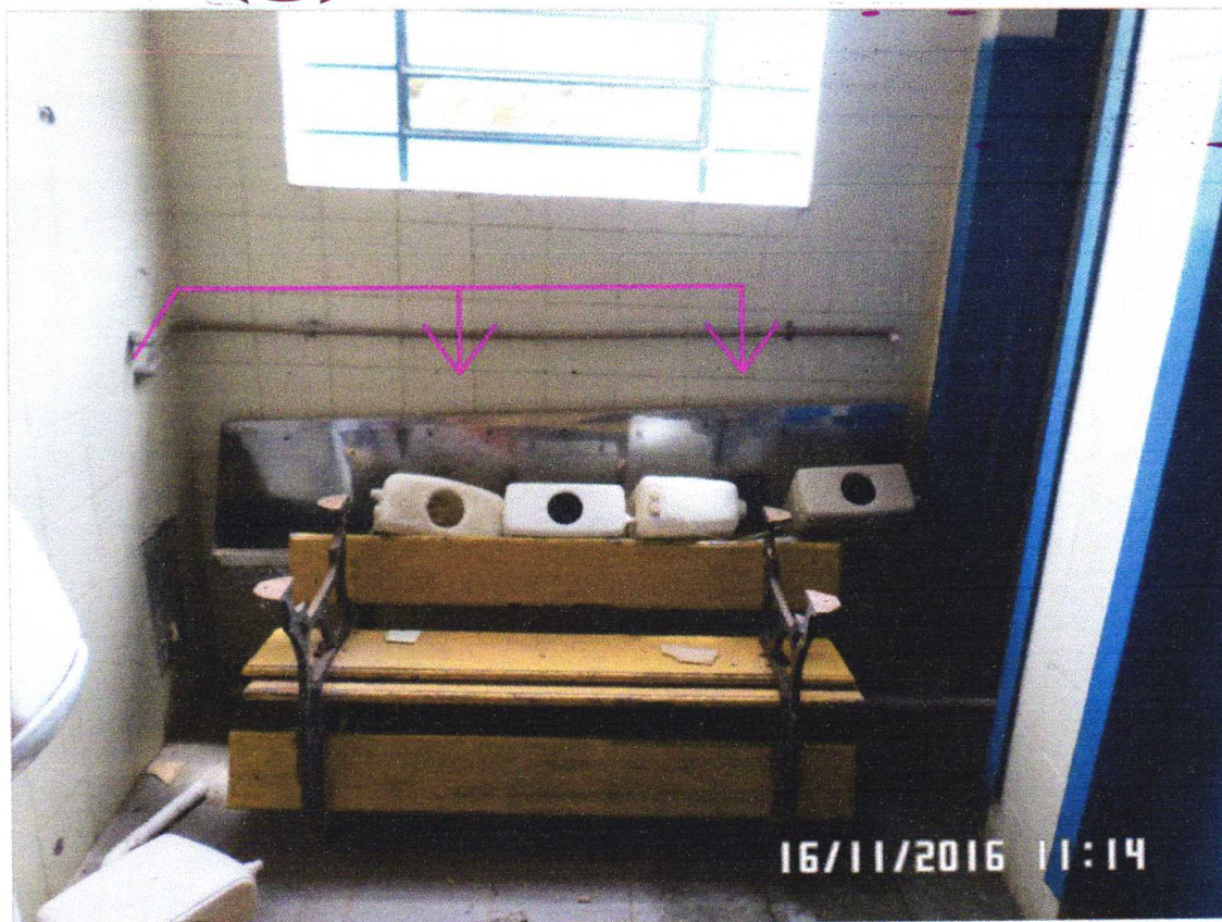
Figura 7: Ponto de água a ser realocado para a instalação de mictórios de louça individuais.
