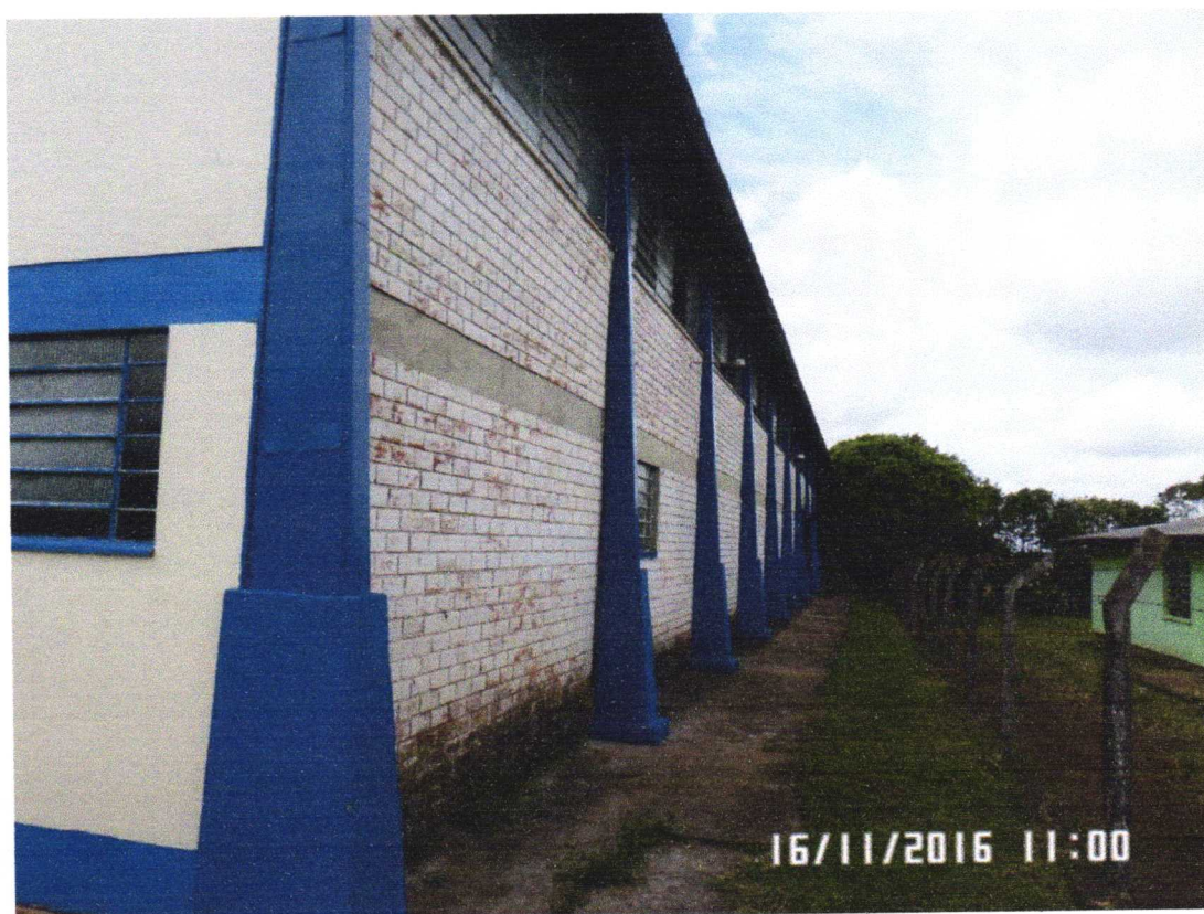
Figura 5: Parede a receber a limpeza com jato antes da pintura.
