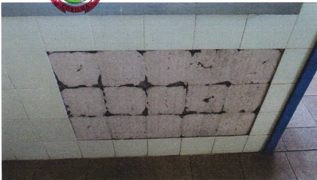
Figura 2: Local com destacamento de peças cerâmicas na copa Nº 02.
