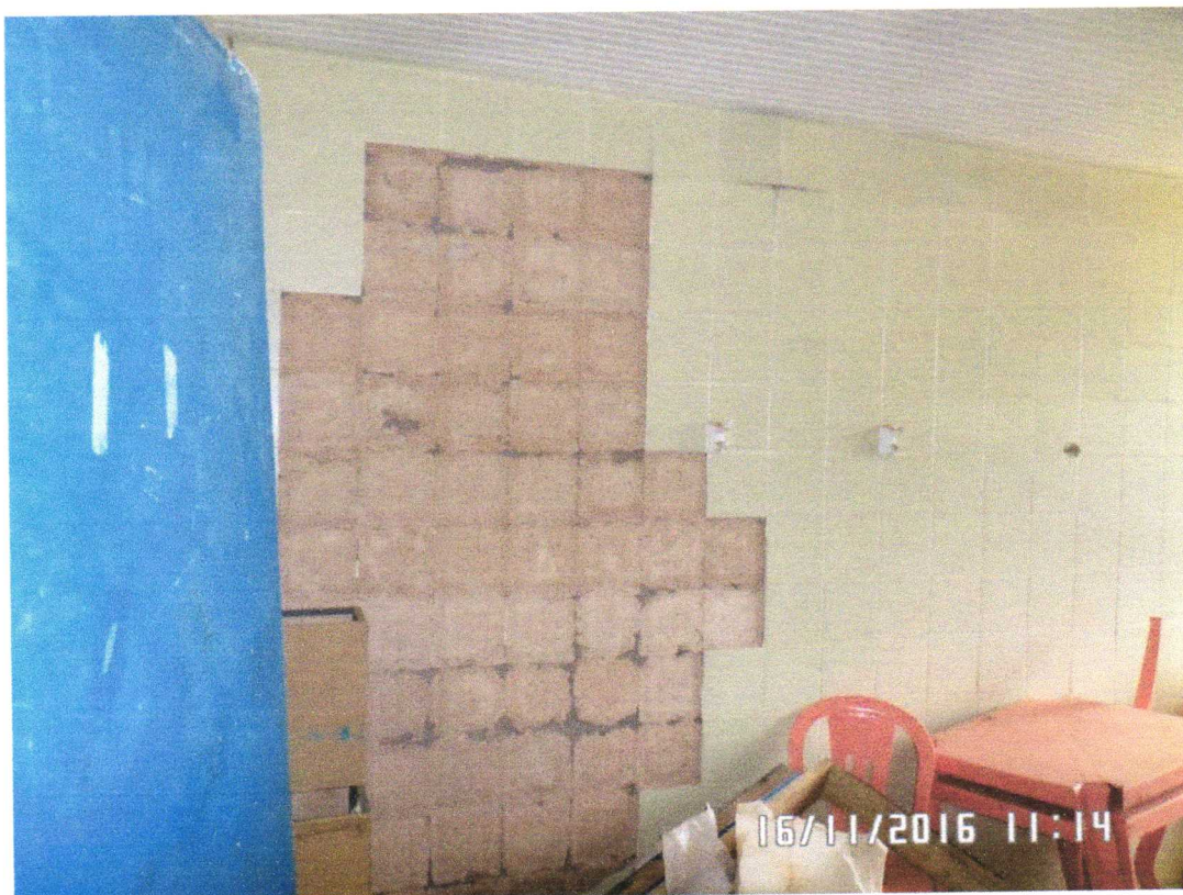
Figura 1: Local com destacamento de peças cerâmicas no sanitário masculino/vestiário masculino Nº02.
