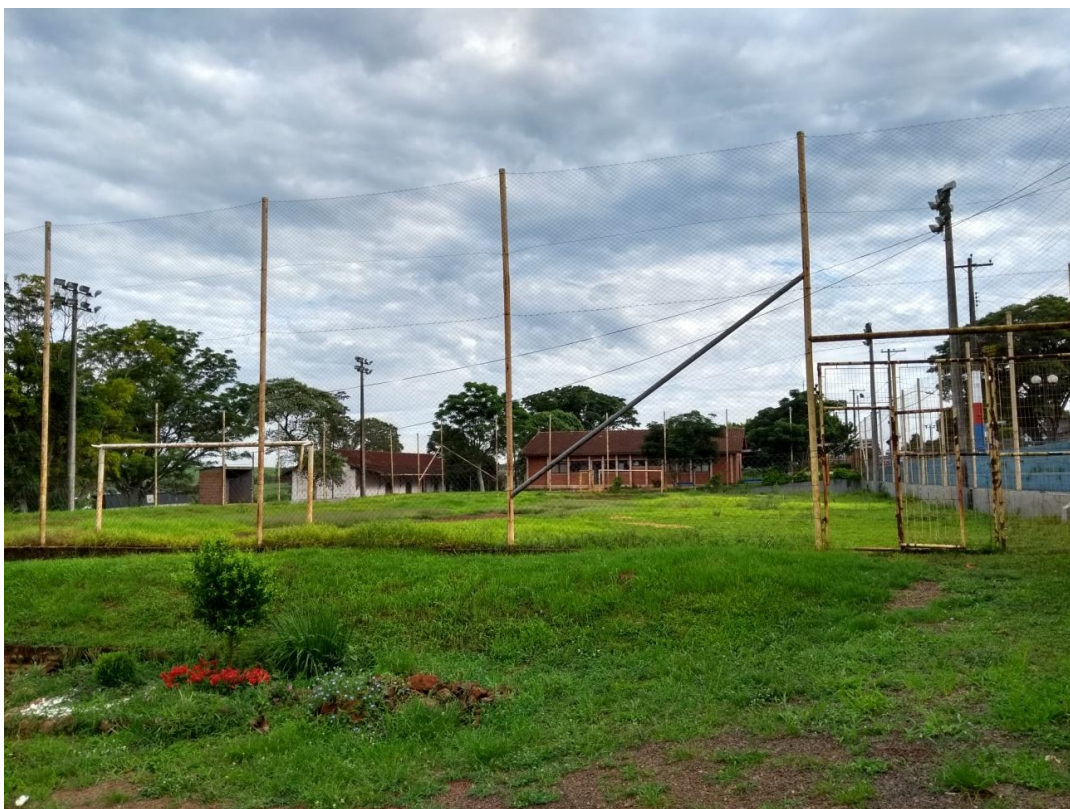
Tela existente no alambrado que será removida.
