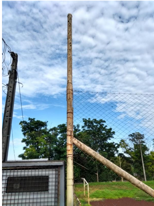
Postes metálicos do alambrado em que a pintura e a oxidação deverão ser removidas.
