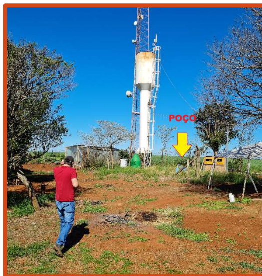
Figura 8 – Foto do reservatório existente e poço artesiano.
