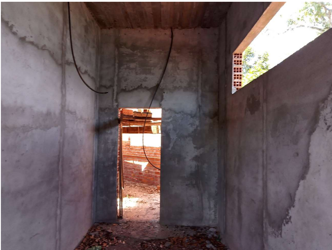
Emboço já existente na sala de carnes.
