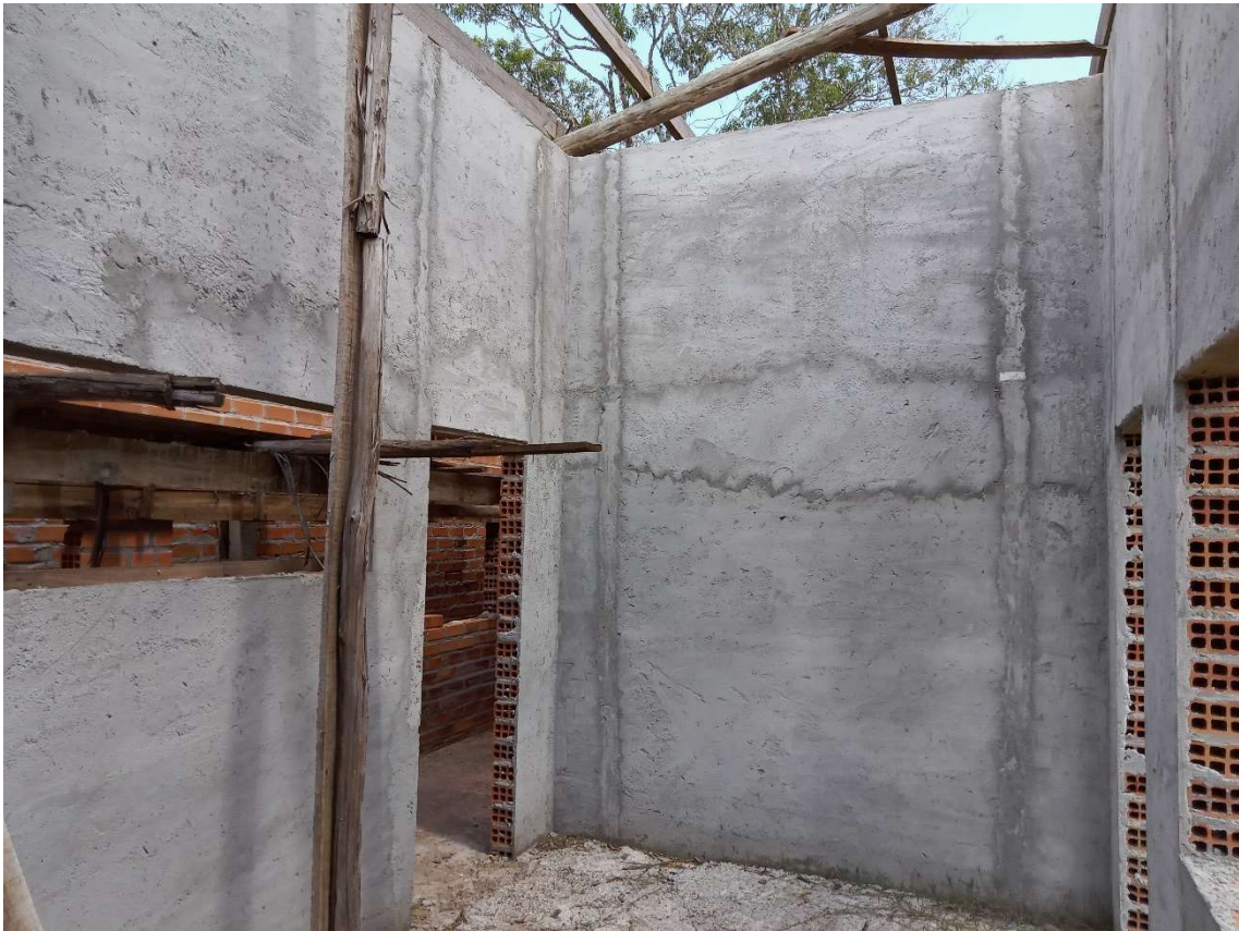
Emboço já existente na cozinha.
