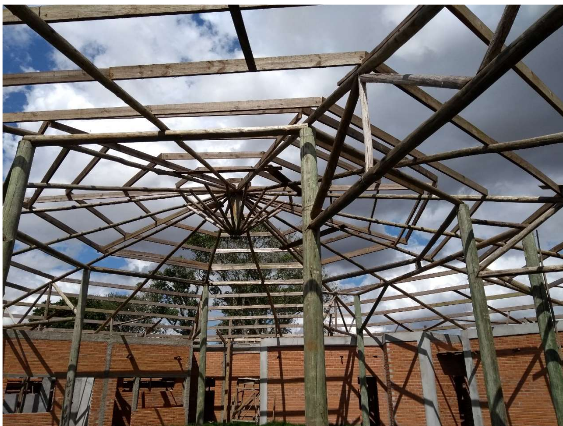
Trama de madeira já existente sobre a qual será instalado o telhamento.
